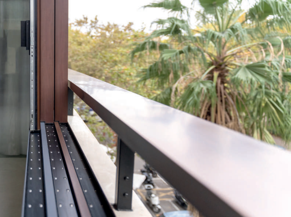
Detalle: barandilla de seguridad y diseño compuesta por aluminio y hierro.
