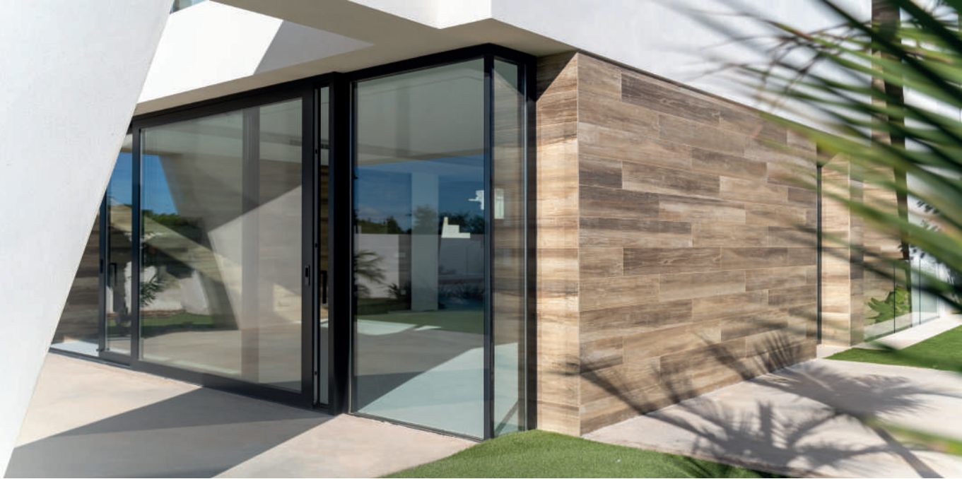
Detalle de vista exterior.
